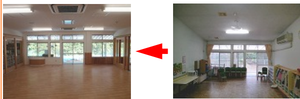
牛ヶ谷保育園 保育室 壁を取り払い、広くなりました。
