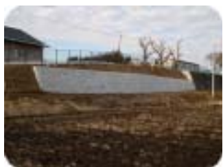
補強され立派な壁に支えられています
